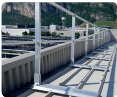
Zábradlí kotvené k podkladu
