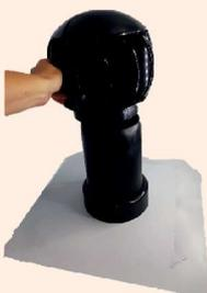
3. Dann montieren wir den Lüftungskopf an das Rohr und testen seinen reibungslosen Betrieb. Der Kopf muss senkrecht montiert werden, da sonst die Gefahr eines ungleichmäßigen Lagerverschleißes besteht und die Turbine nicht richtig funktioniert.
