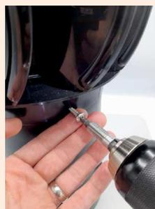
4. Der Kopf wird mit drei selbstschneidenden Schrauben, die in die vorbereiteten Löcher eingesetzt werden, gegen Wegblasen gesichert.
